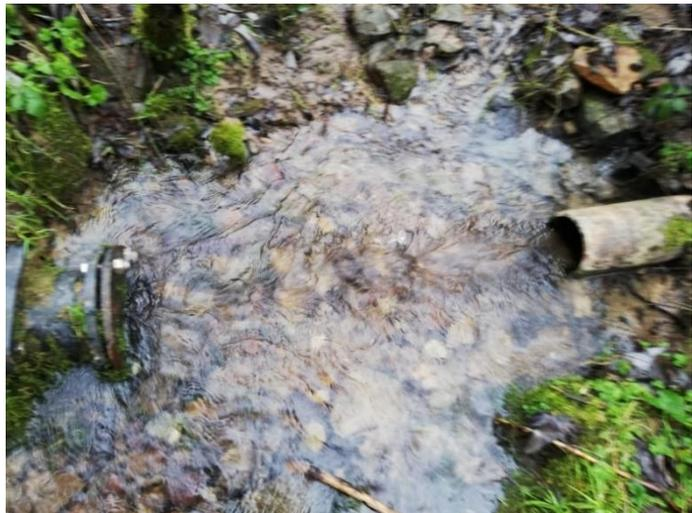
Unsere Recherchen haben ergeben, dass es sich hierbei um einen alten Zulauf zu dem dort weiter westlich befindlichen Behälter handelt, welcher in den 90er Jahren im Rahmen von Sanierungsarbeiten gekappt wurde. Man sieht den verschlossenen Zulauf im Bild links.
